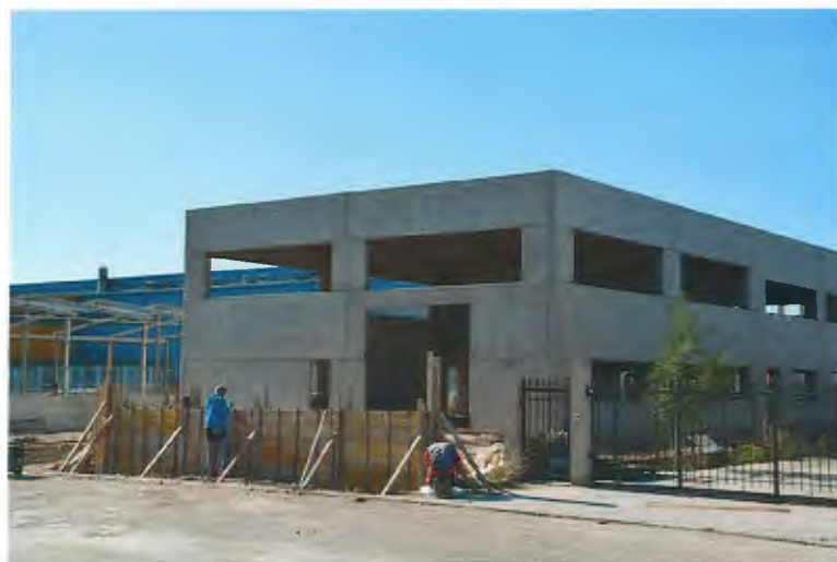
Radovi na hali tvrtke Capax d.o.o., Ražine
