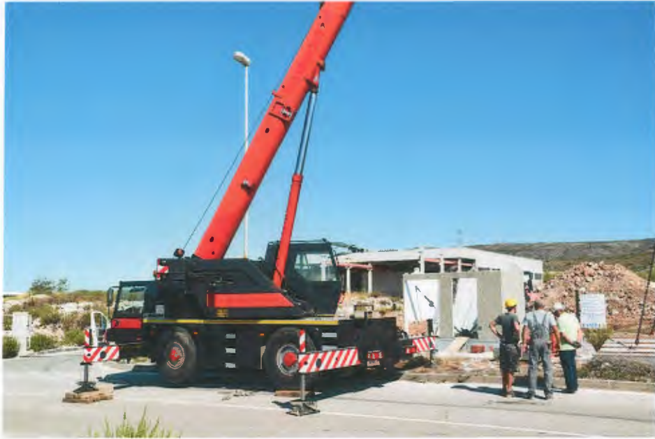
Postavljanje nove trafo stanice
